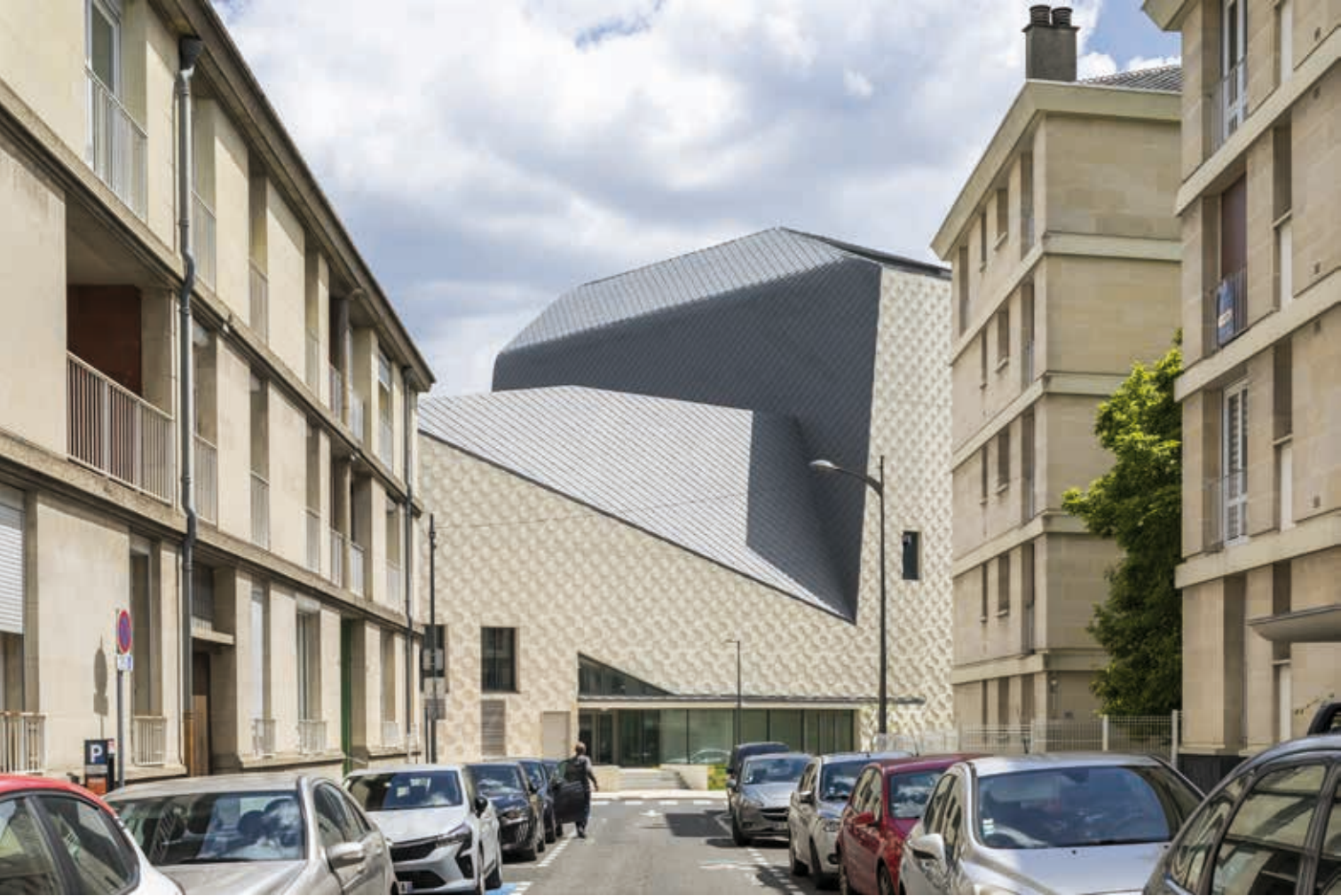
▲ Le dôme de la cage de scène présente la particularité d’abriter les espaces techniques, ce qui représentait une gageure technique, la volumétrie s’en trouve magnifiée.
